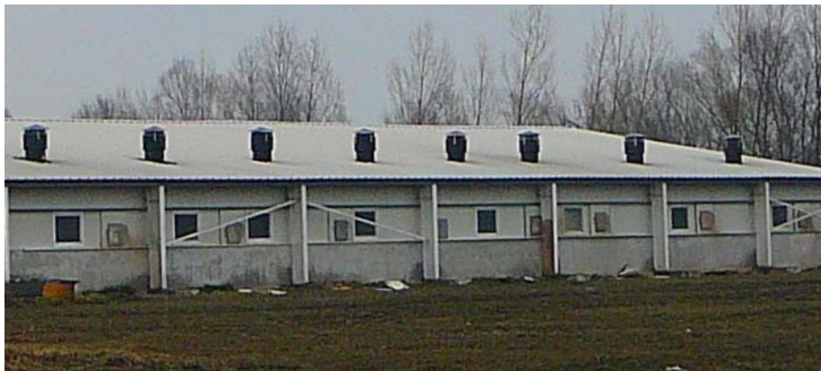
5. sz. kép: A tetőn lévő szellőző kürtők, ill. az istálló falába épített légbeejtők.
